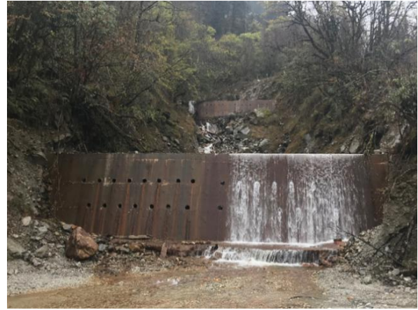
(d) permeable type of retaining dam
