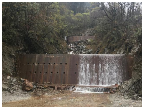
(d) permeable type of retaining dam for debris flow
