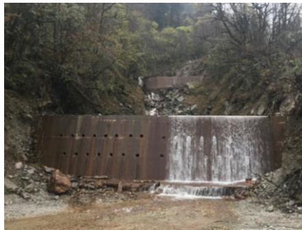
(d) permeable type of retaining dam
